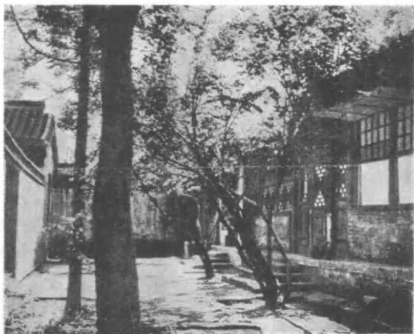
北京八道灣十一號周宅
