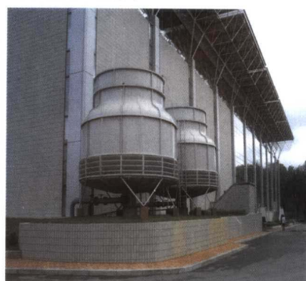
⑥中央空调现场的冷却塔
