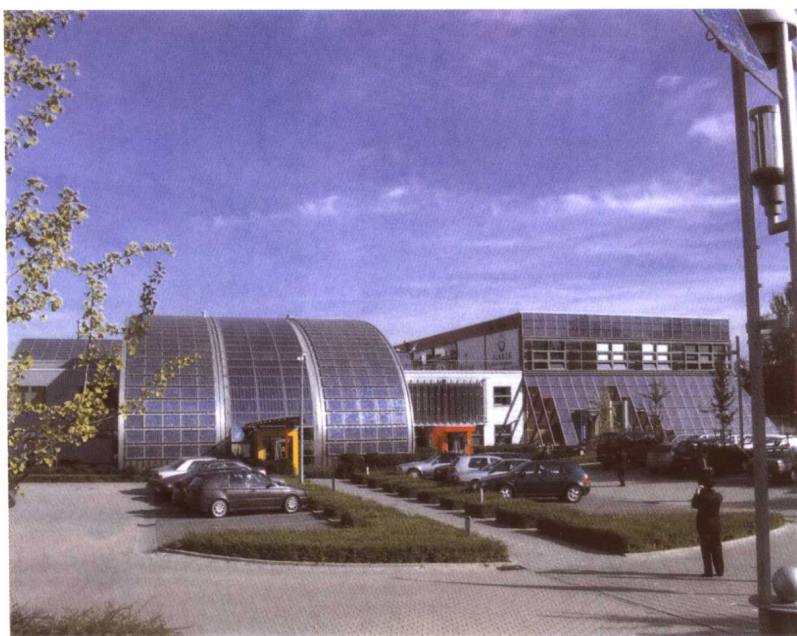
⑪德国的太阳能建筑一体化(光伏)
