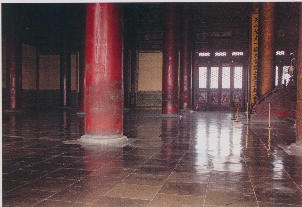
图4 太和殿的金砖地面
