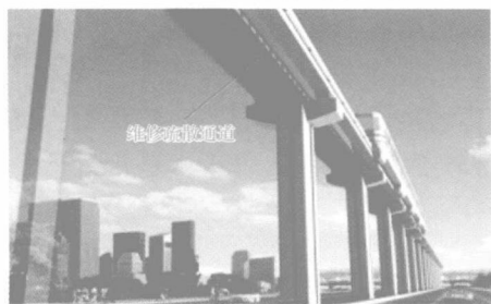
图 1-10 单轨交通维修疏散通道
