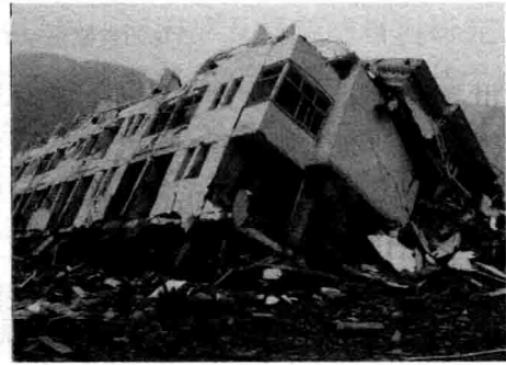
图 1-10 映秀镇龙口中学七层建筑倒塌
