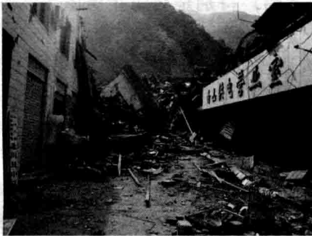
图 1-11 地震现场的山体滑坡
