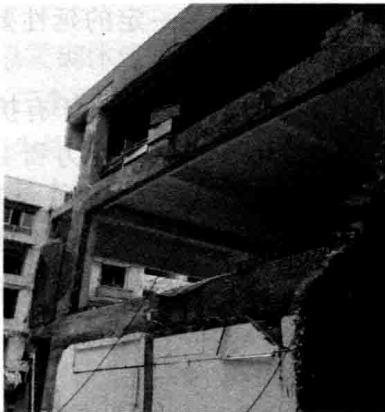
图 1-13 填充墙破坏（整片甩出）
