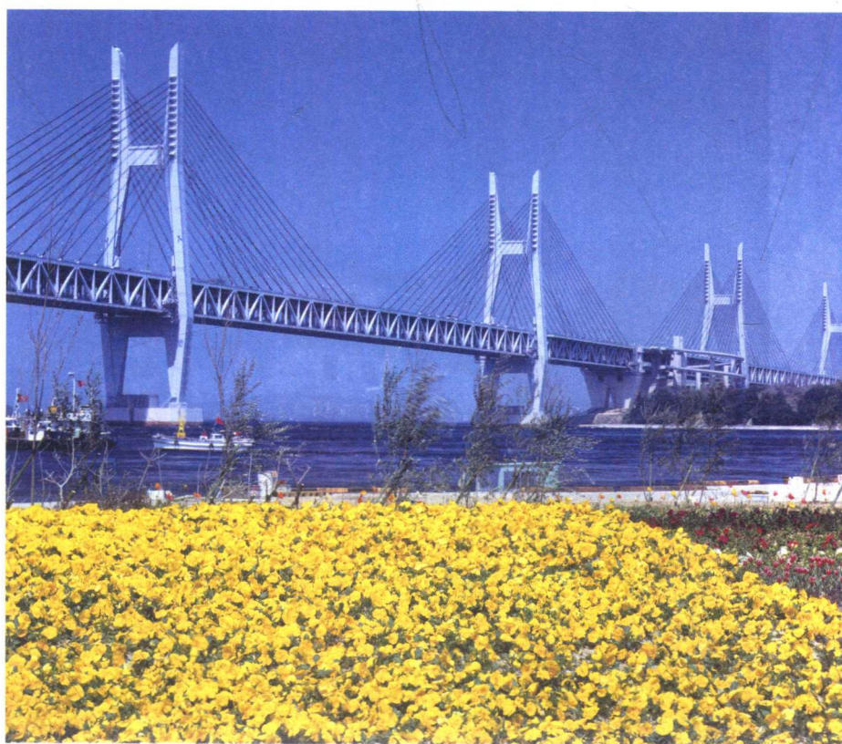
香川县瀬户大桥
