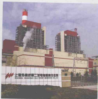
上海外高桥第二发电有限公司
