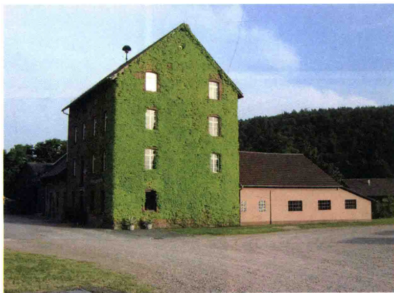
▲ 建筑物外墙上的常春藤
