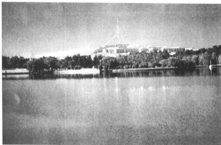
图 1-1-23 建成后的澳大利亚国会大厦保持了原来小山包地形不变，只是中部加了一个旗杆以突出它的存在 （摘自《Architecture Australia》1988.11）
