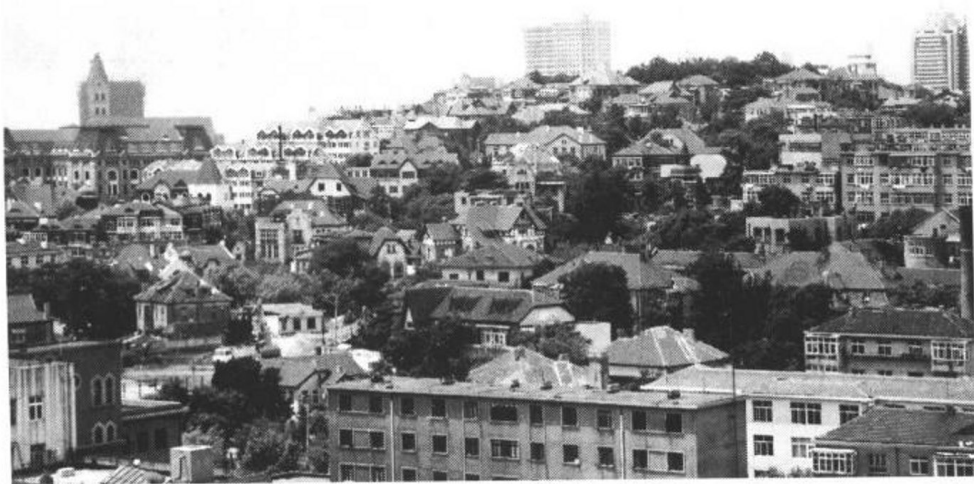
图 1-1-8 青岛市区内后来陆续兴建的高层建筑，有损于富有特色的城市总体面貌
