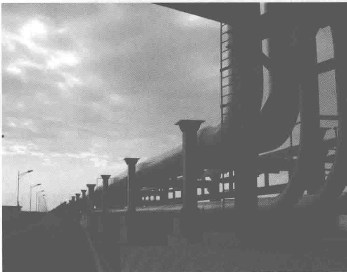
图 1.2-3 污水陆上输送管线
