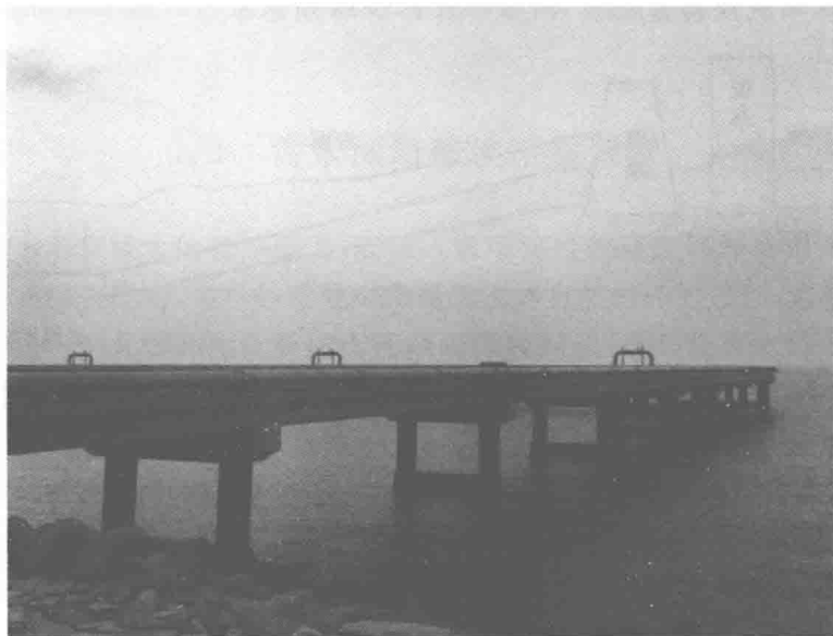
图 1.2-4 污水海上输送管廊
