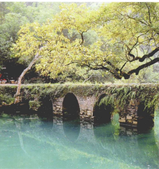
图1-21 贵州荔波漳江国家级风景名胜区 小七孔景区，青石砌七孔拱桥
