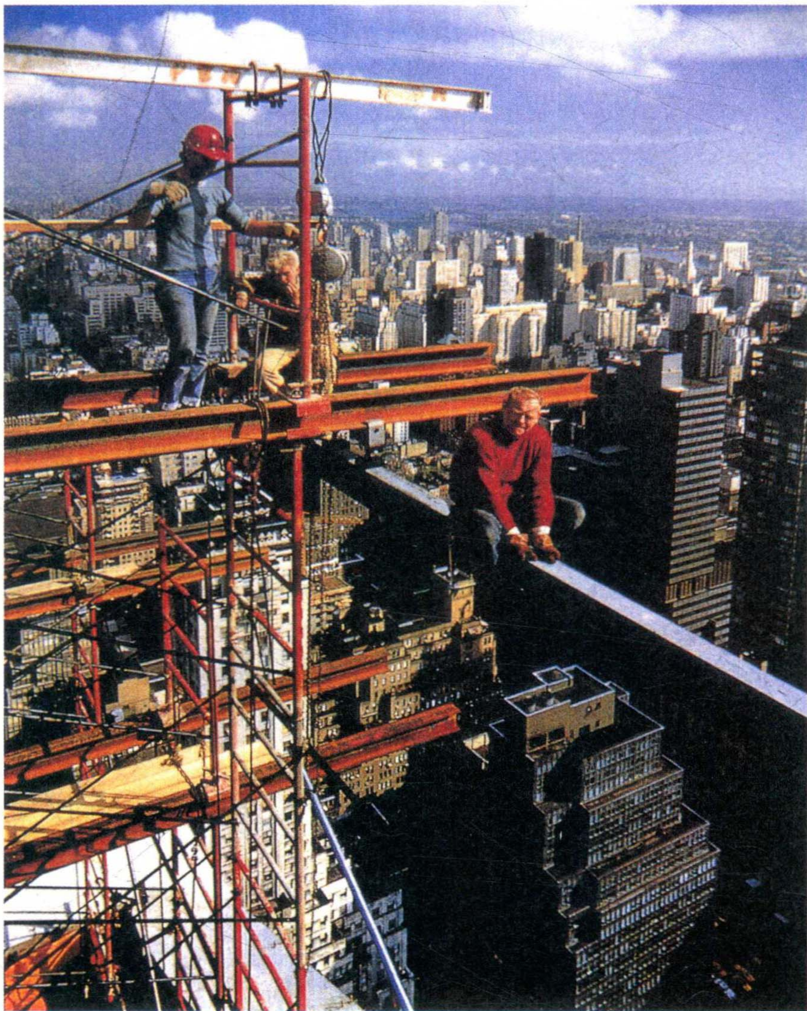
美国摩天楼建筑施工一瞥
