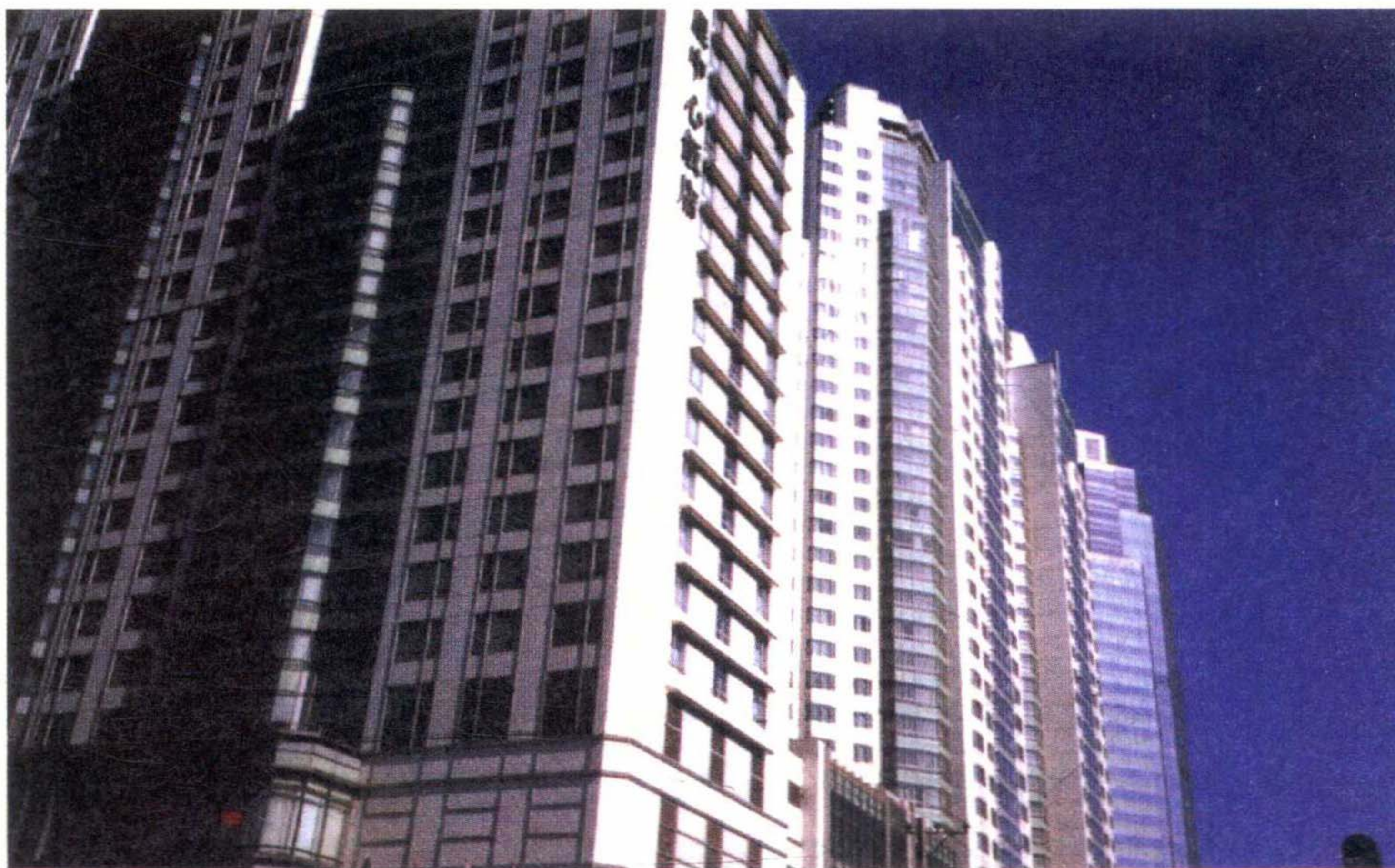
北京新住宅楼
