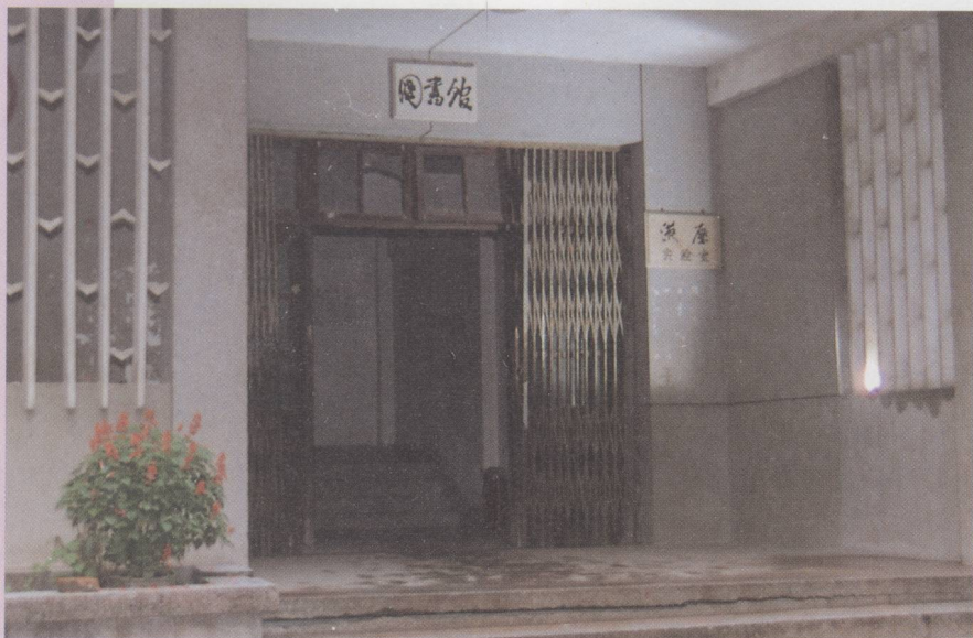
广东省建筑工程专科学校图书馆
