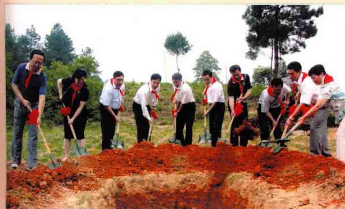
民进中央副主席朱永新等为民进常熟希望学校教学楼奠基
