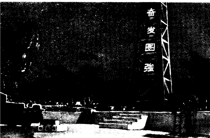
船尾抢修工地
