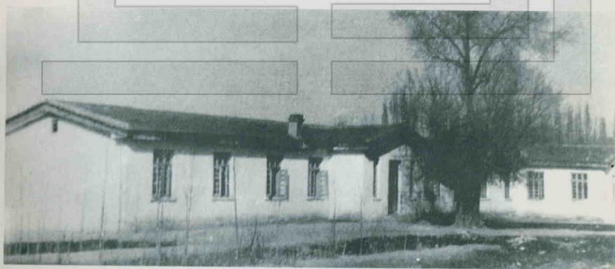
1951—1954 年二十二兵团工程处办公室(石河子)。
