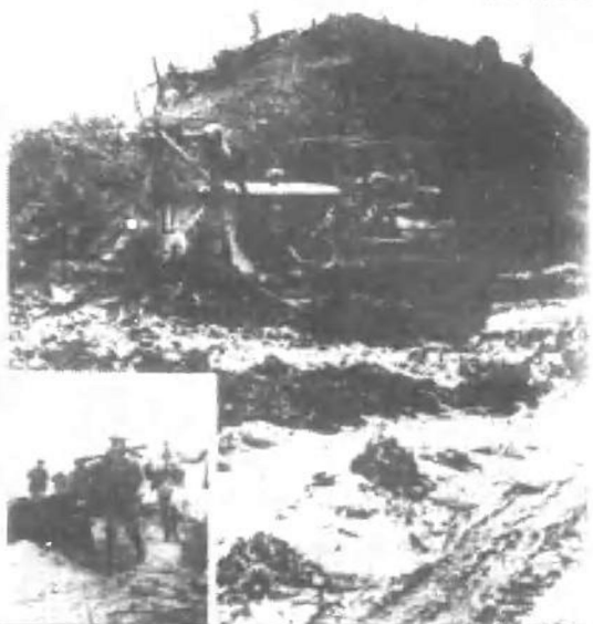
◁ 中美工程队在泥水中抢修 中印雷多公路
