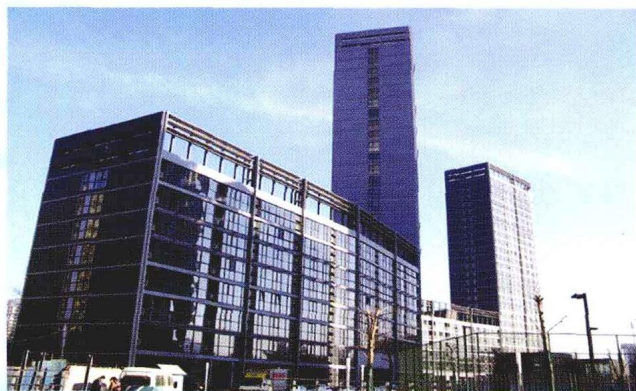
客四9#楼实景图
