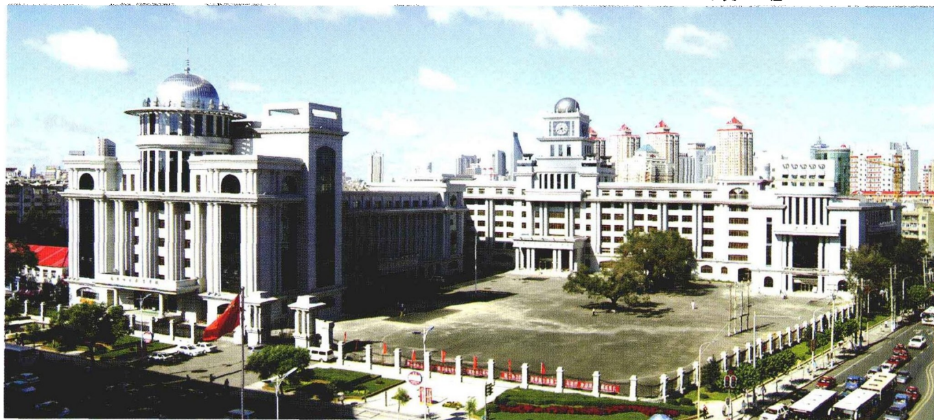
哈尔滨市马家沟学校工程——获 2005 年度“中国建筑工程鲁班奖”
