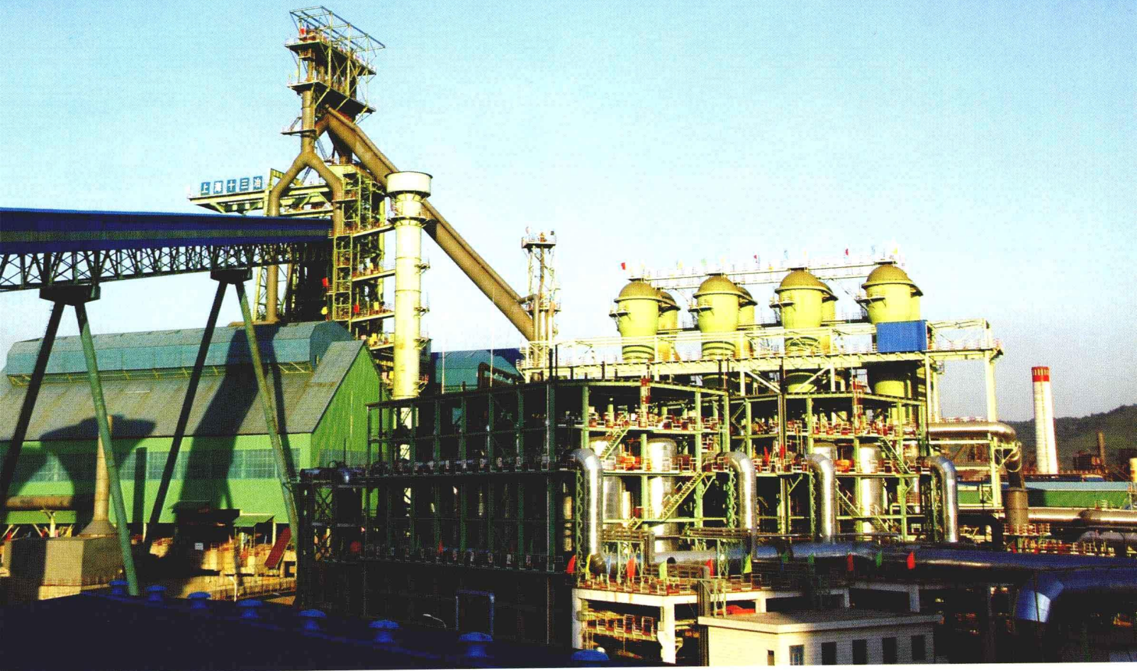
中冶华天总承包的华南地区最大高炉工程 (广东韶钢松山股份有限公司 7 号高炉工程)
