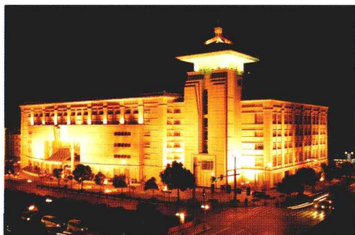
苏州国税综合业务大楼 (2004 年度鲁班奖)
