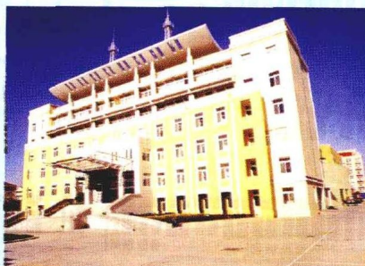
江苏边防总队太仓海警支队办公楼 合楼(10875M 2 K6 获2003年度“扬子杯”奖、2005年全国用户满意工程)
