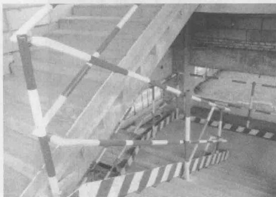
图 1.8 楼梯临时扶手
