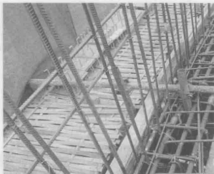
图 1.15 连墙杆件
