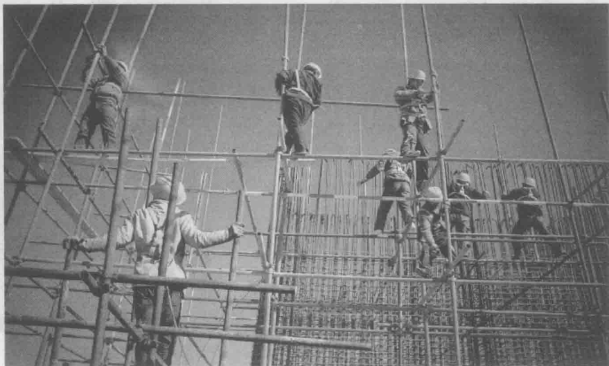
图 1.3 脚手架安装
