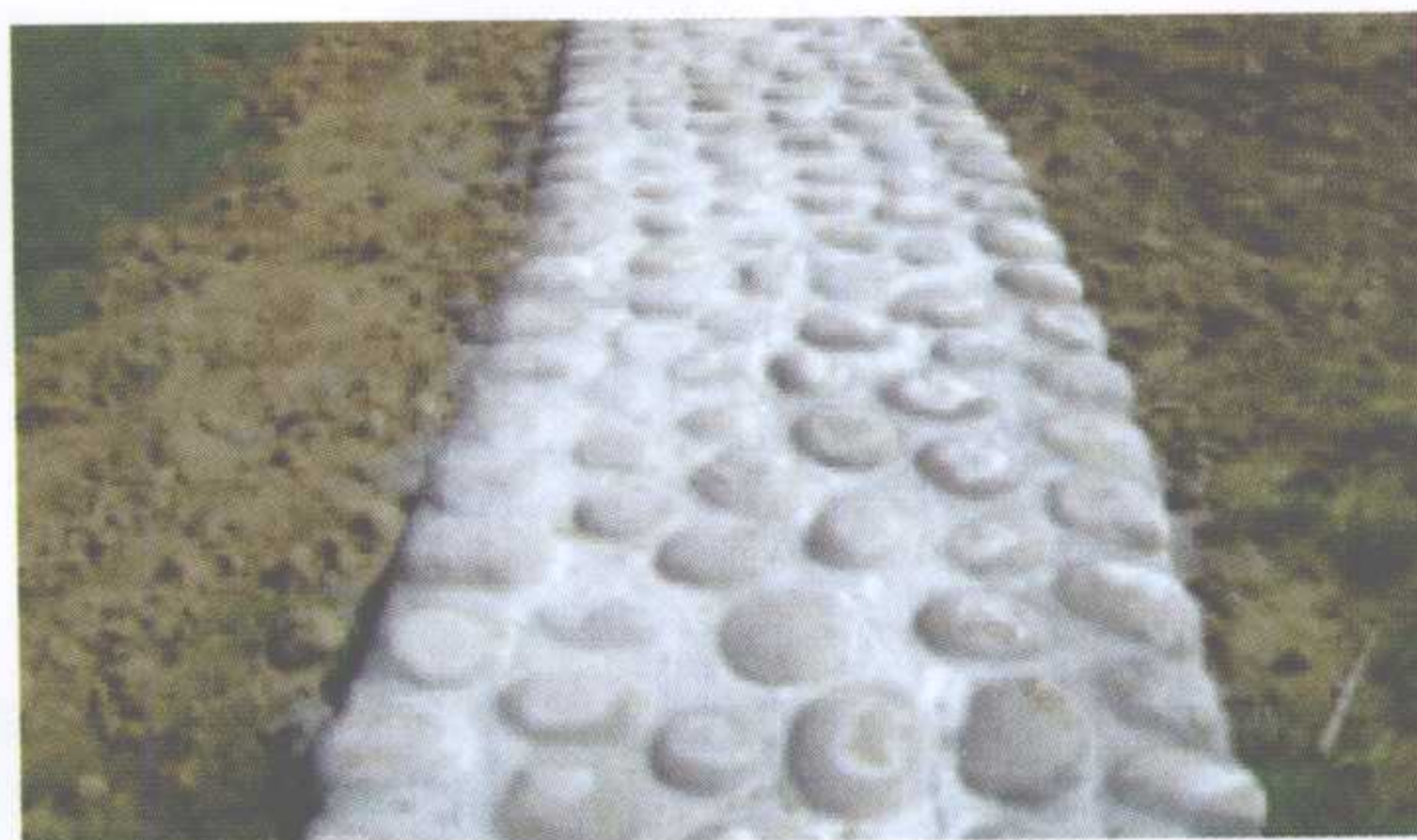
彩图 2-22 正在施工中的大块卵石园路
