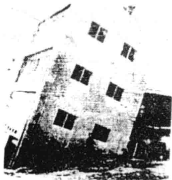
图 1.10 地基液化导致建筑物倾斜
