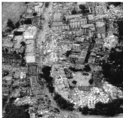
图 1.9 汶川地震的建筑物倒塌破坏
