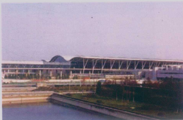
图 1-10 浦东机场二期航站楼楼屋面外板
