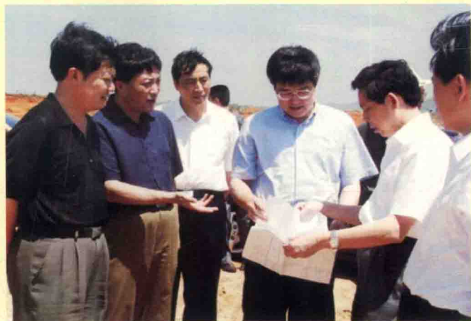
2006年8月21日，副省长孙刚视察国电黄金埠电厂建设工地。
