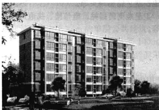
(a) 某住宅楼
