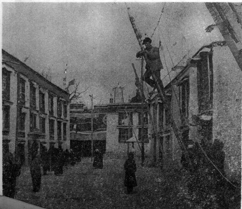
拉薩市的秩序正在迅速恢复。这是拉薩电厂工人在修复电綫。
