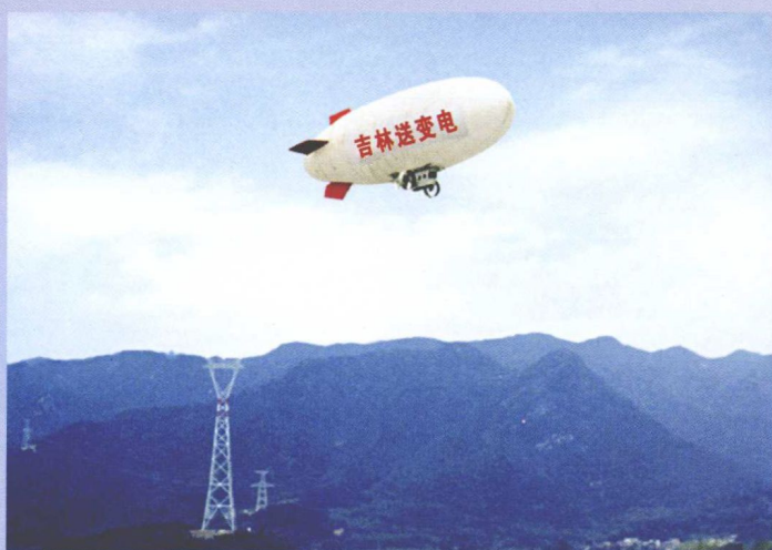
国产遥控飞艇用于电力工程山野布线
