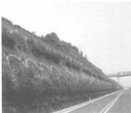
图 1.9 路基坡面防护
