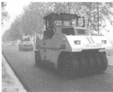
图 1.3 沥青混合料路面
