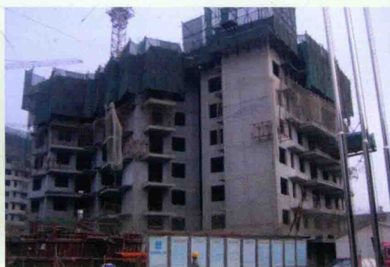
图 4-7 剪力墙结构房屋
