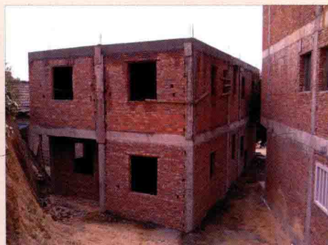
图 4-5 砖混结构房屋
