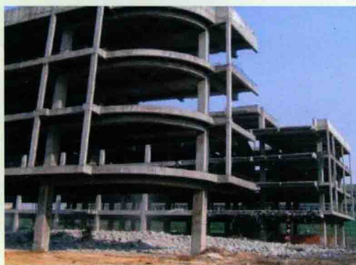
图 4-6 框架结构房屋
