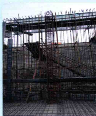
图 2-10 钢筋混凝土结构
