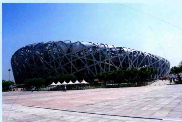
图 2-9 大跨度钢结构
