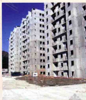
图 4-2 钢筋混凝土结构高层住宅楼
