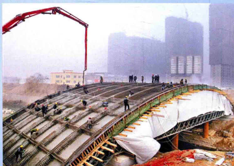
图 2-4 混凝土浇筑
