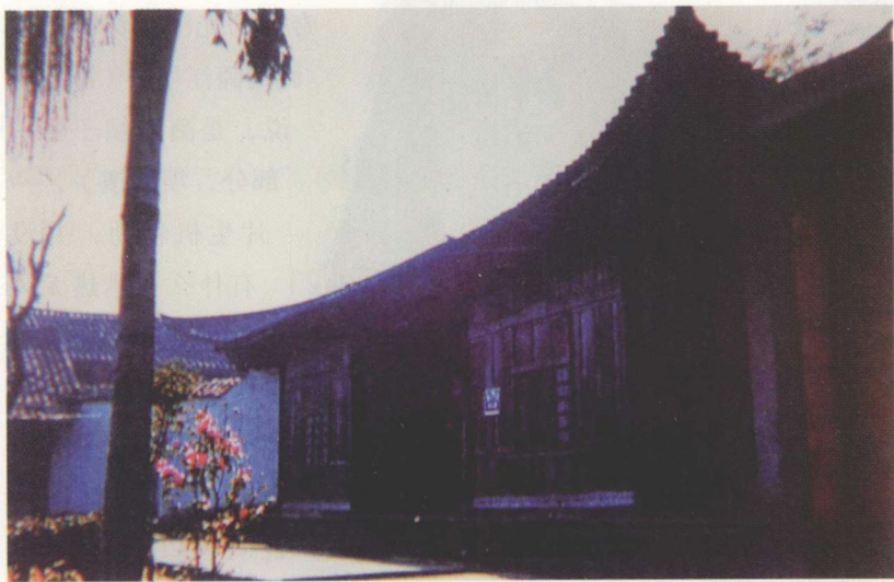
腾越海关旧址
