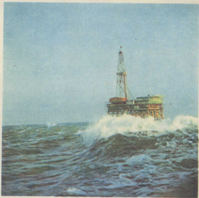
⑧ 渤海的海上石油钻井平台
