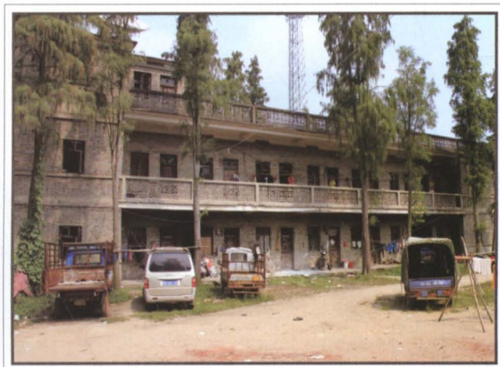
原云楼乡政府办公楼
