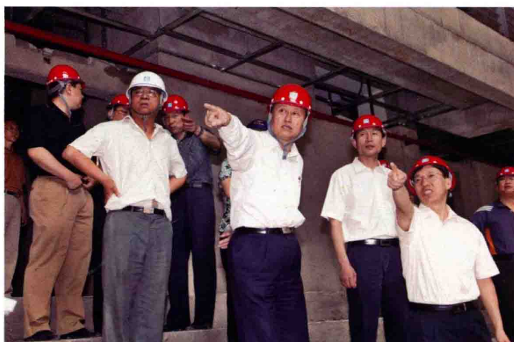
2007年6月9日， 北京市教工委书记朱善 璐视察奥运乒乓馆建设 工程
