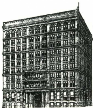
图3: 家庭保险公司(Home Insurance Building)(1885年), 巴隆·詹尼(Baron Jenney)+惠特尼(Whitney), 柱梁均为铁制的芝加哥学派的最早的真正意义上的高层建筑
