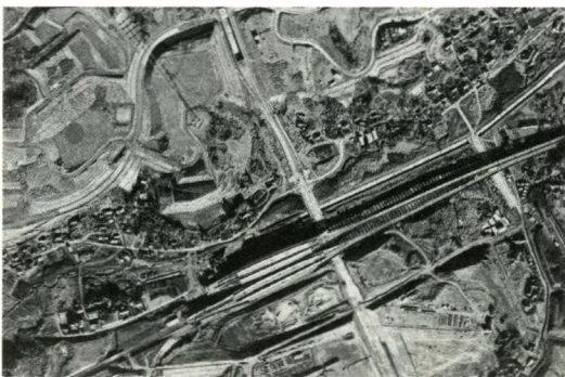
图 12: 多摩中心站周边航拍（1974 年）
