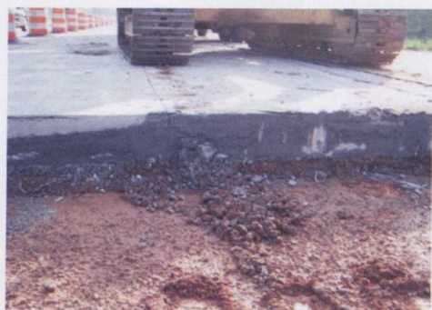
图 1-8 维修中展现出的路面结构
