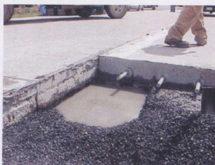
图 1-9 维修过程中降雨带来的积水
