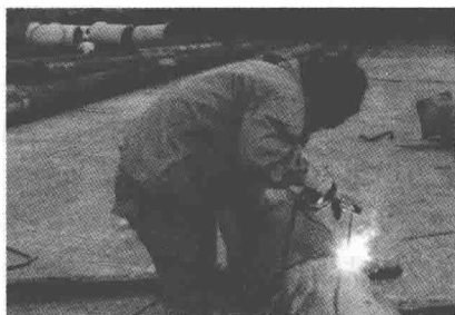
图 1.8 钢管焊接连接
