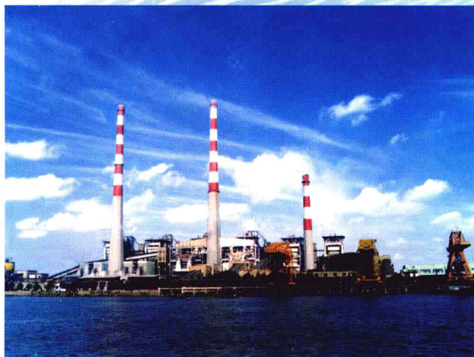
闵行发电厂全景
