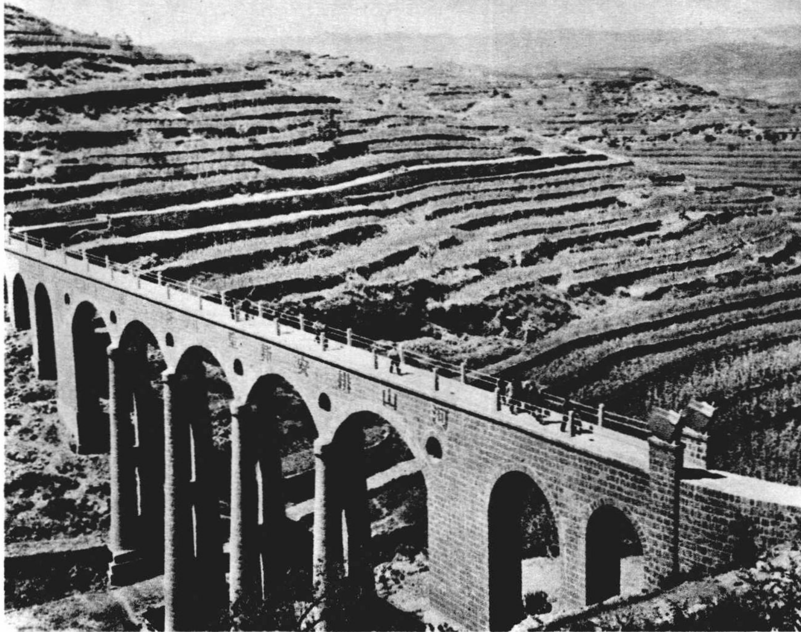
雄伟壮丽的大寨团结沟渡槽。
