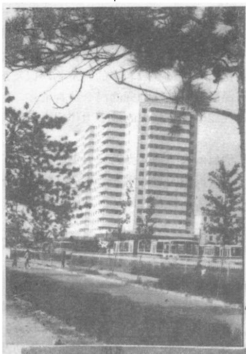
图 1-2 北京 木樨园小区钢筋 混凝土住宅
