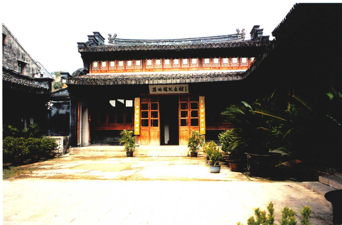
9 玉海楼故居厢房
