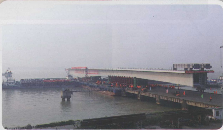
整跨钢箱梁滚装上船 >>
