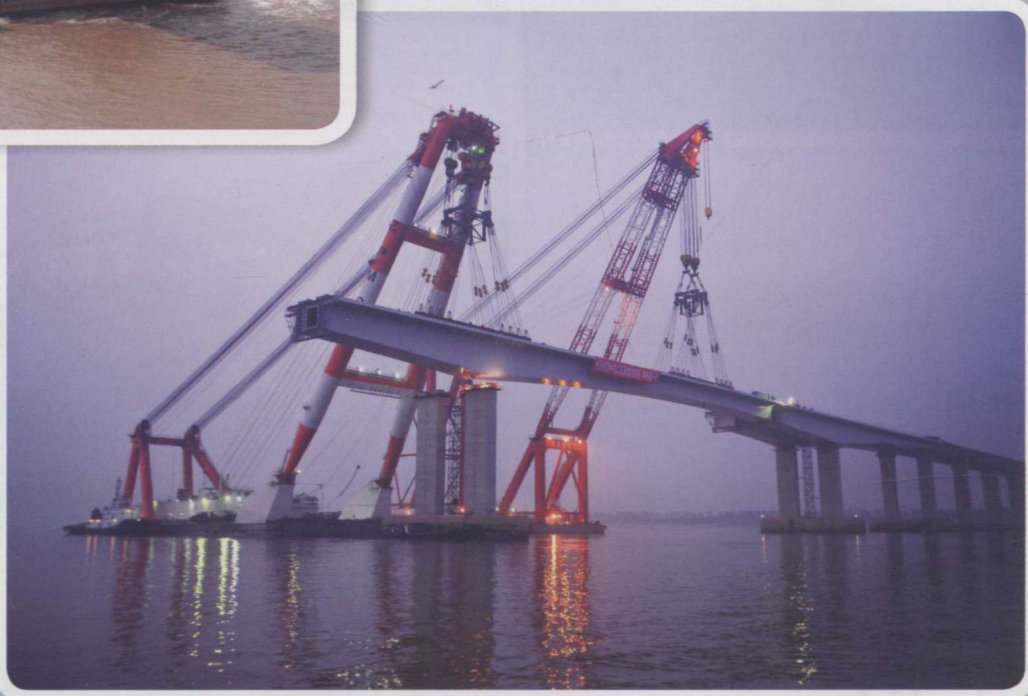
整跨钢箱梁现场吊装 >>
