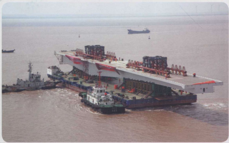
<< 整跨钢箱梁水上运输
