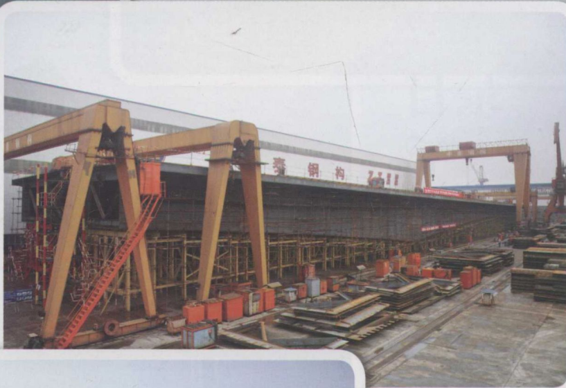
钢箱梁节段制造拼装 >>
