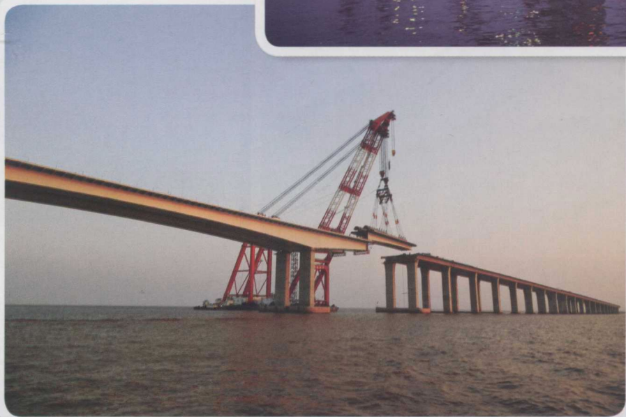
<< 最后一节段钢箱梁吊装
