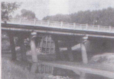
图 1-2 1~3 号墩柱平行向河心倾斜滑移
