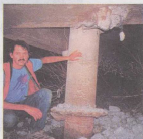
图 1-6 桩体拔出
