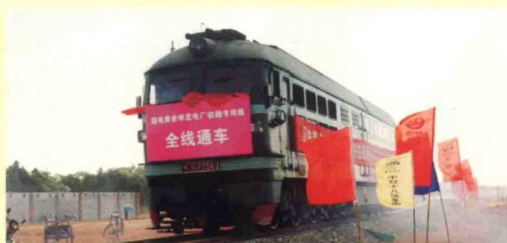
2005年11月30日，国电黄金埠电厂铁路专用线建成通车。
