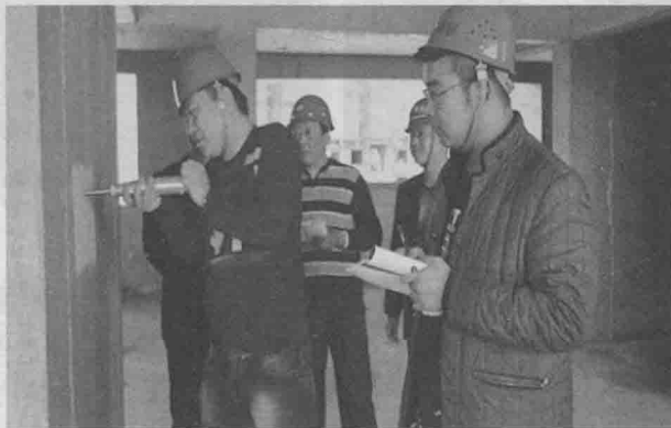
图 1.3-8 回弹法检验混凝土强度
