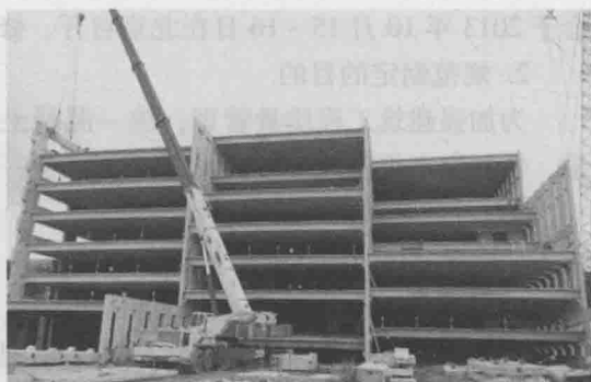
图 1.3-5 装配式混凝土结构
