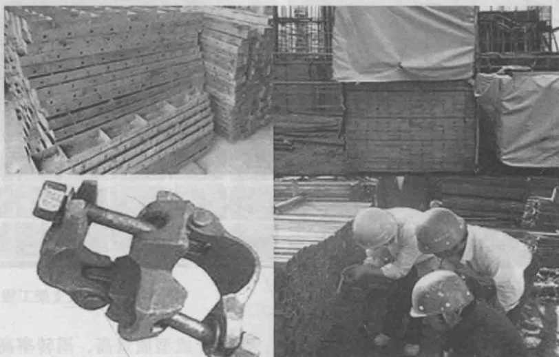
图 2.1-5 进场材料检查
