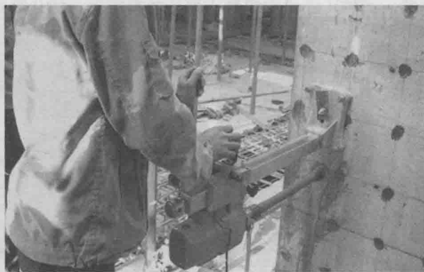
图 1.3-9 钻芯取样检验混凝土强度
