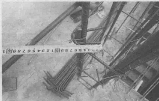
图 2.2-1 箍筋平直段长度检查
