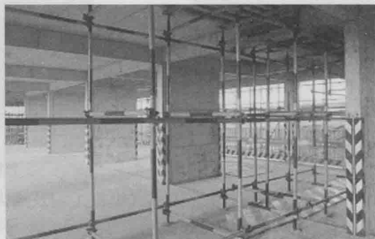
图 2.1-4 后浇带独立支撑系统
