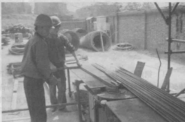
图2.2-4 钢筋弯折
