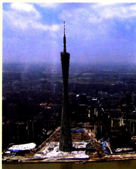
广州塔(新电视塔)主体结构完成后的概况
