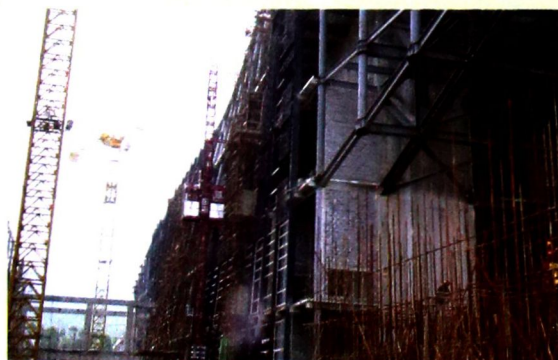
正在施工的会议中心部分的主体结构
