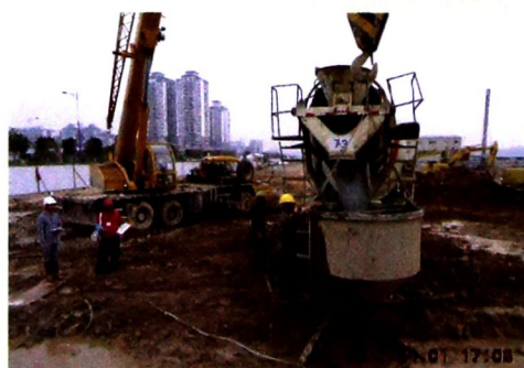
珠江新城某项目旋挖灌注桩正在水下浇筑混凝土
