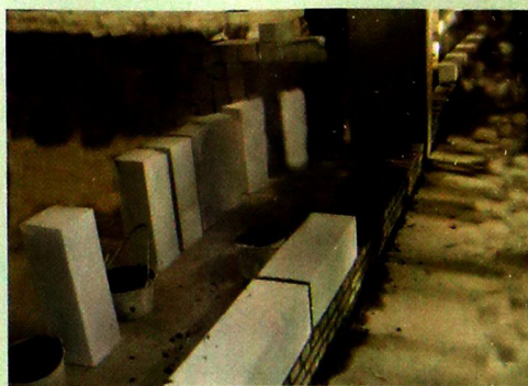
用泡沫混凝土砌块砌筑内隔墙的施工现场
