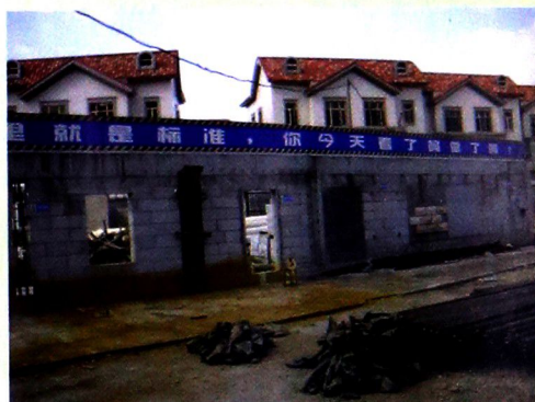
某楼盘工地做的样板墙
