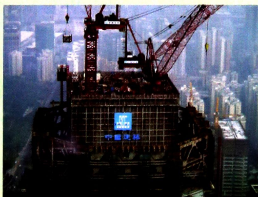
广州珠江新城东塔（周大福大厦）的主体结构施工
