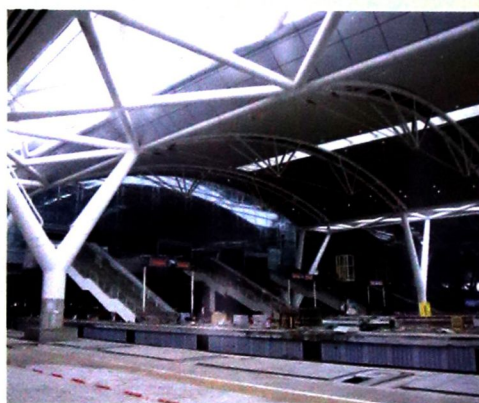
广州火车南站站台部分正在施工
