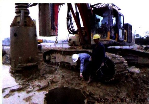
珠江新城某项目旋挖灌注桩正在施工
