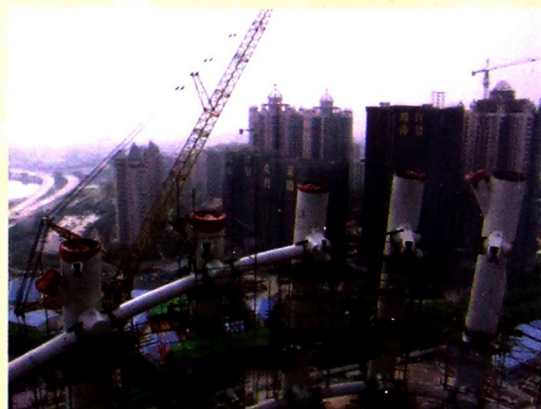
正在高空安装施工的塔体上段
