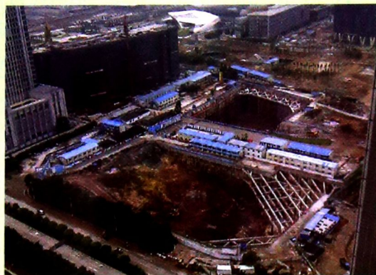
广州珠江新城东塔（周大福大厦）的基坑支护施工
