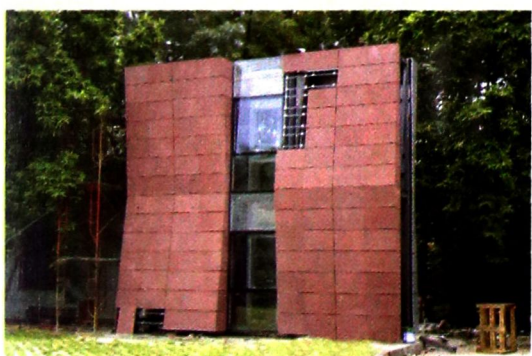
建筑外立面部分采用干挂石板，图为正式施工前做的样板墙
