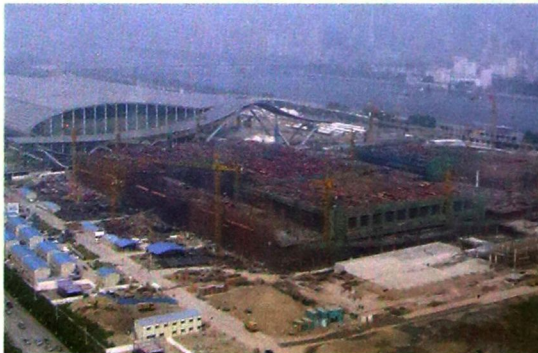
正在施工的会展中心二期工程
