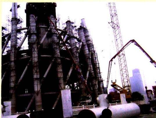
塔身下段钢结构安装，钢管柱用布料杆泵车浇筑混凝土
