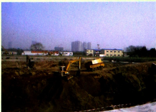
土方施工现场
