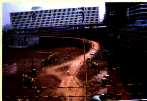
广州珠江新城西塔基坑支护和土方开挖施工现场
