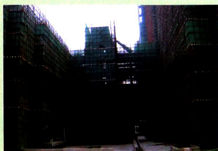
广州科学城某建筑的外墙脚手架
