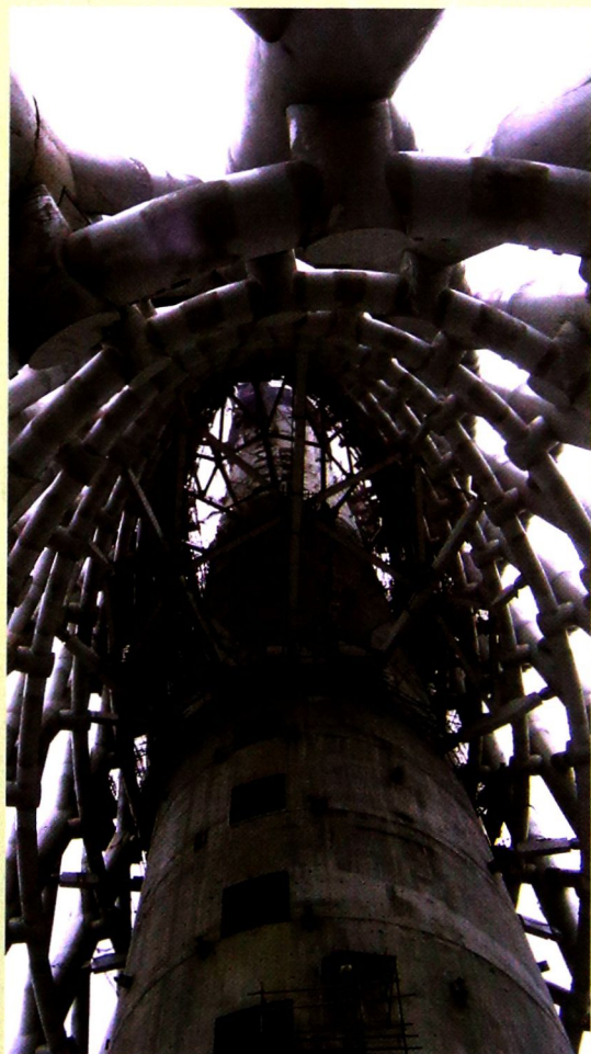
混凝土核心筒与外框筒的组合内观
