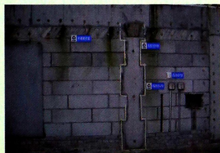
样板墙的局部
