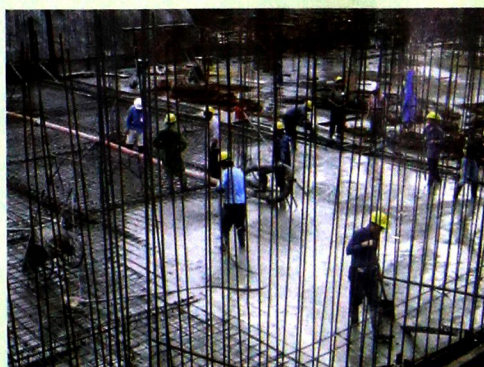
某地下室用泵送混凝土浇筑
