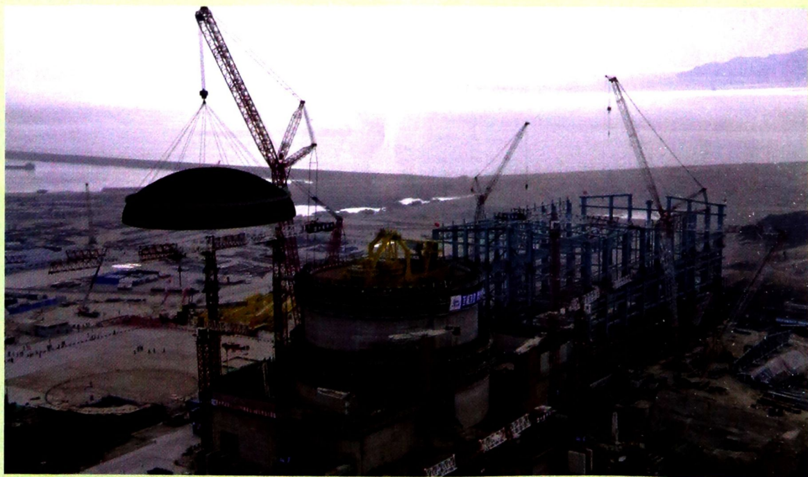
广东台山核电站1号机组核岛顶盖吊装
