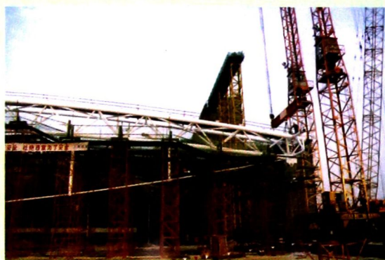
张弦桁架现场制作后，用4台吊车起吊上轨道滑移就位
