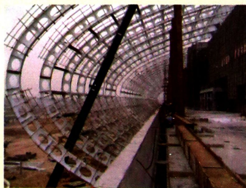
正在施工的卡车通道，焊接H型钢曲梁结构
