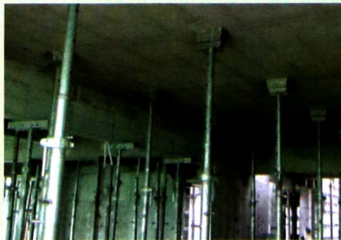
铝合金快拆模板体系可先拆模保留支撑后拆
