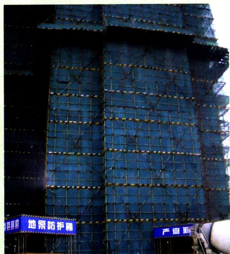
广州从化某住宅楼项目的外墙脚手架
