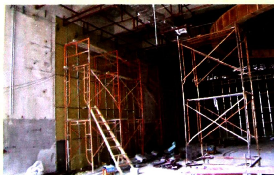
正在施工的会议室的隔声墙和吊顶
