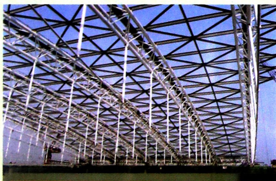
一个展览大厅的张弦桁架屋面系统组装完成
