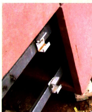
干挂石板的构造
