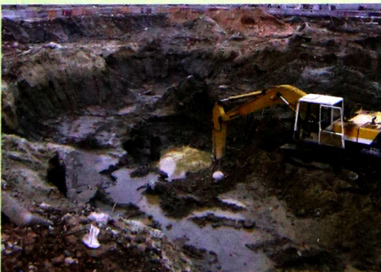
基坑用集水坑集地表水，挖土机挖土，自卸汽车将土方运至就近的珠江边，然后用船运走
