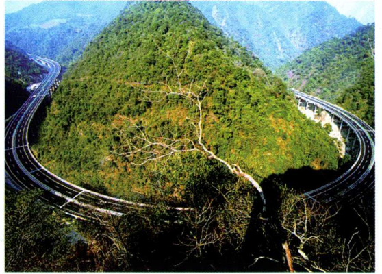
图 13 福建漳龙高速公路
