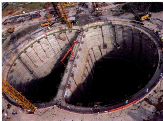
图3 地连墙施工
