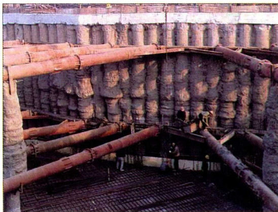
图4 深基坑支护
