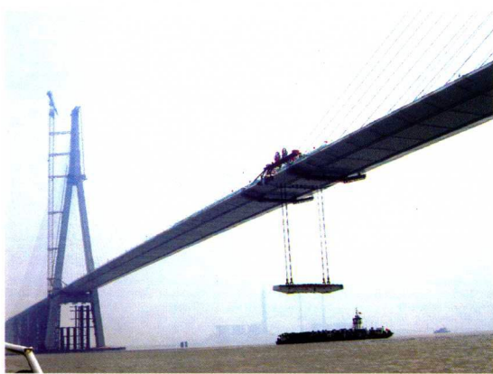
图 22 苏通大桥“合龙块”施工
