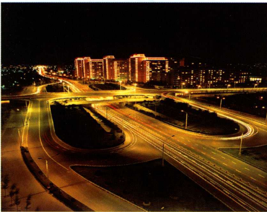
图 16 广州城市立交桥
