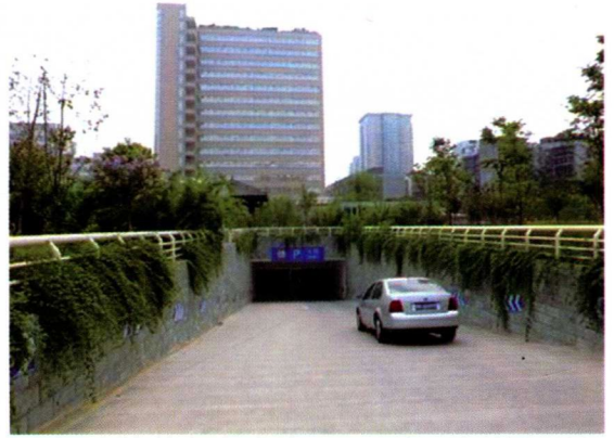
图 27 地下停车场入口
