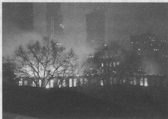
图 1-1 动力楼火灾现场图片
