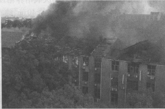
图 1-5 化学化工学院火灾现场图片
