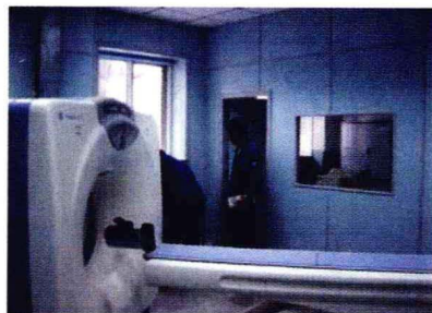
防火板饰面射线防护机房
