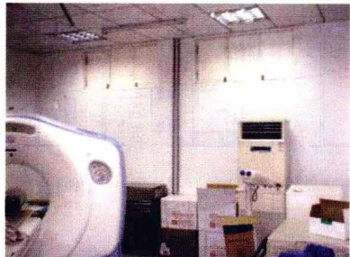
防火板饰面射线防护机房
