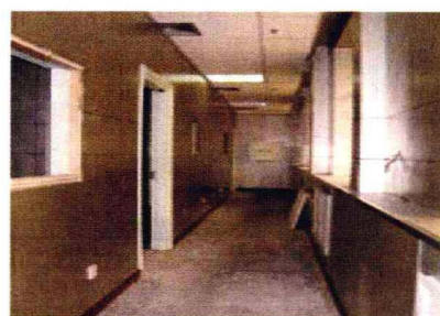
铝塑板面轻钢龙骨防护隔墙
