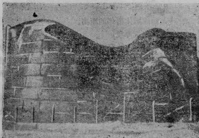
图 1 由于真空太大而发生的油罐外壳凹陷
