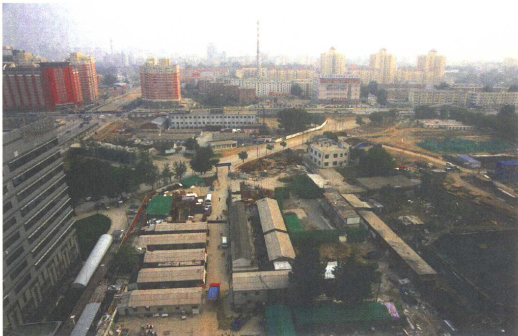
2003 年，建设中的清华科技园
