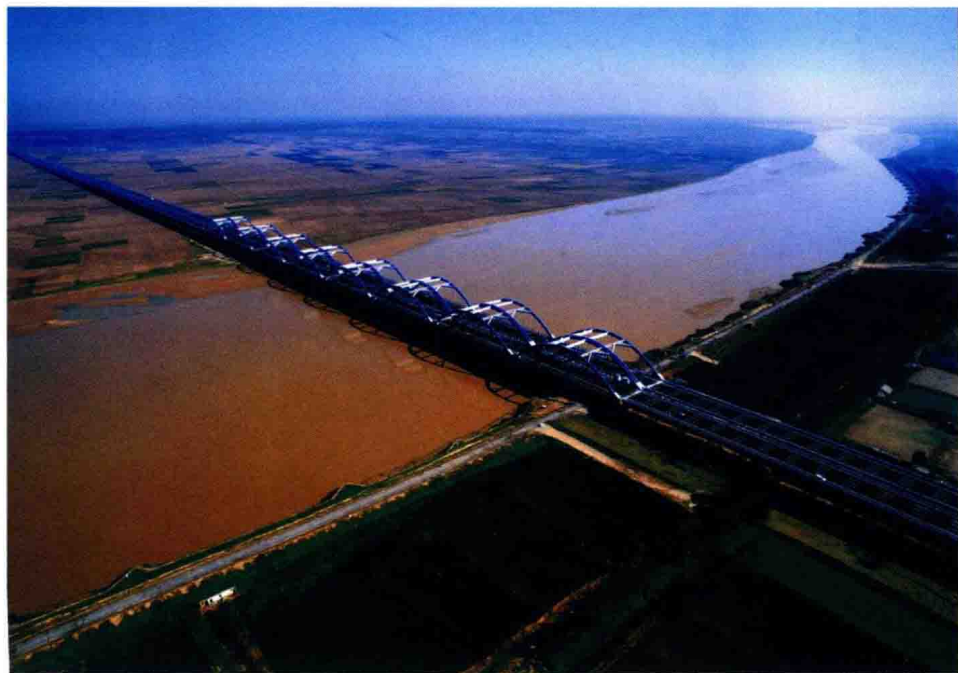
▲ 京港澳高速公路黄河大桥
