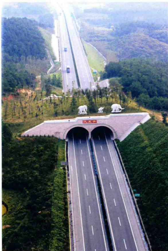
▲ 京港澳高速公路豫鄂界九里关隧道
